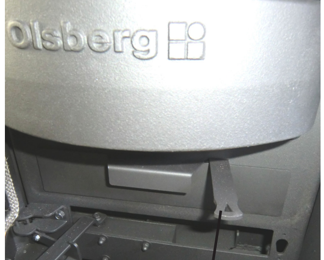
Bedienhebel für den Feuerrost
